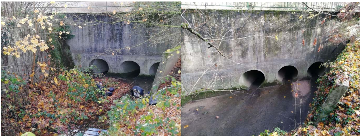
Figure 15 : Photos du pont existant rue des Montées
